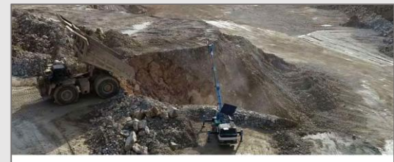
[2020実証-4] コア中四国カンパニー、みちびきを活用した石灰石の採掘支援
