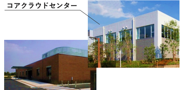
コアクラウドセンターWEST
