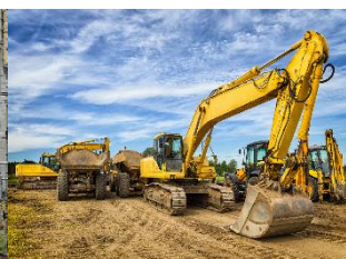
施工状況記録
