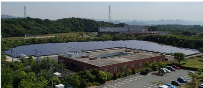
【「コア山口太陽光発電所」に設置した太陽光パネル】
