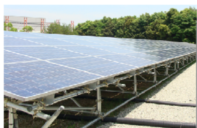
【太陽光パネル】
